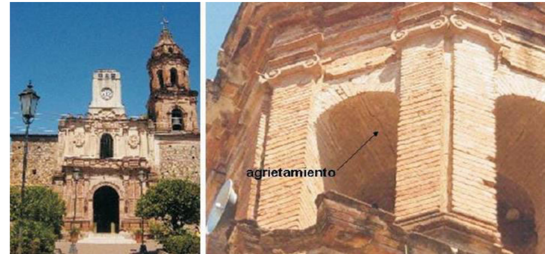
Imagen 17.- Fachada principal de la iglesia San Juan Bautista en la ciudad de Huetamo., fuente: Ciencia Nicolaita No.49, Pág. 166, en línea en: [http://goo.gl/4rgvsJ], octubre de 2014.
