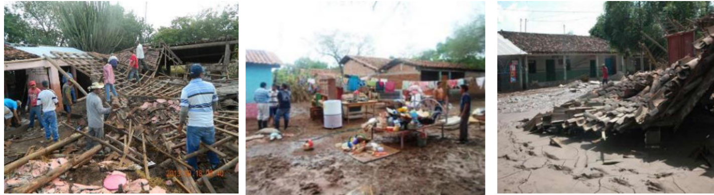
Imagen 33.- La tormenta tropical Manuel arrasó viviendas y comercios en el municipio de Huetamo, Michoacán. En la imagen, labores de limpieza en el poblado San Jerónimo, Foto Rafael Ochoa.
