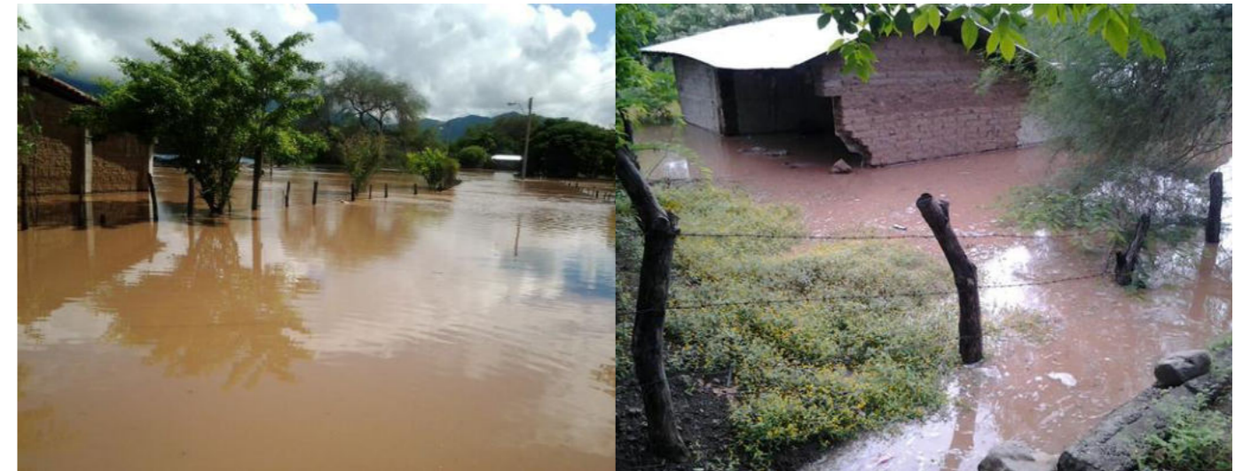
Imagen 32.- El agua penetró hasta el interior de las viviendas, causando daños en la estructura y algunos muros de adobe.
