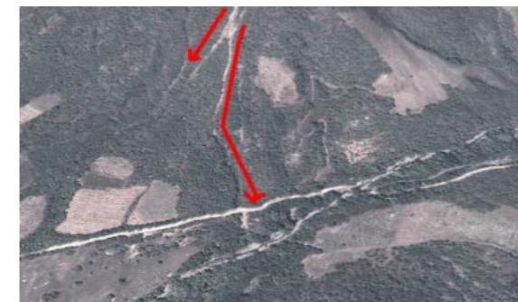
Imagen 62 Derrumbe cerca de la comunidad de Irámuco, dejándola incomunicada. Fuente elaboración propia con imagen obtenida de Google Earth
