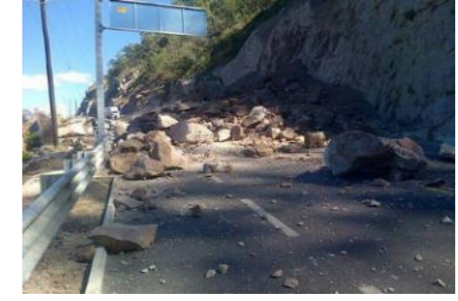
Imagen 61 por lo general los caídos o derrumbes suelen aparecer en carreteras [http://goo.gl/TrdnTP]
